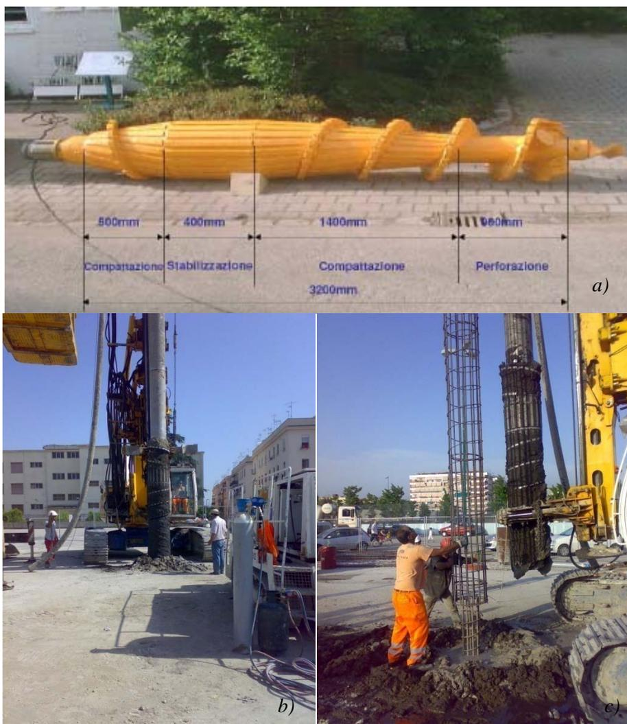
*Figura 1. Utensile del palo FDP (a) e principali fasi esecutive: infissione dell'utensile (b) e posizionamento gabbia di armatura a getto completato e ancora fluido (c).*
