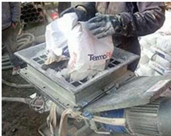
**Fig. 9 – Pompa di iniezione del grout geotermico.**
