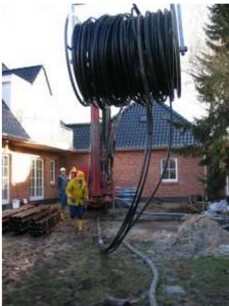
**Fig. 7 – Preparazione alla posa in opera di una sonda geotermica a U doppia.**
