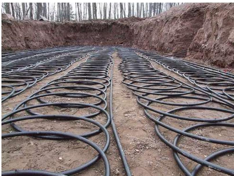
Fig. 12 – Installazione di un impianto a sonde geotermiche orizzontali di tipo “earth coils”.
