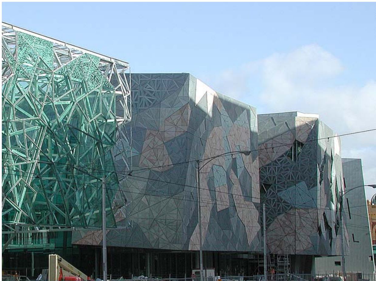
La tassellazione del mulino a vento di Charles Radin, per il Palazzo della Federation Square , , Melbourne, Australia. Fotografia di Paul Bourke.
