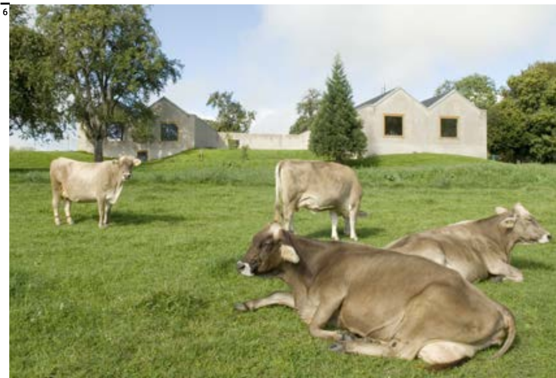
Fig. 6 Maison et atelier à Pampigny, LVPH, 2011 (foto Jérôme Humbert).
